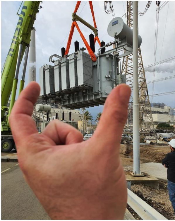
בתמונה: מהנדס חשמלאי פז רוט 'מודד' את השנאי הישן בעת ההנפה. ברקע ניתן לראות את השנאי החדש ומיכל הקונסרבטור המוגבה מעל מבודדי מתח-עליון, בניגוד לשנאי הישן.
